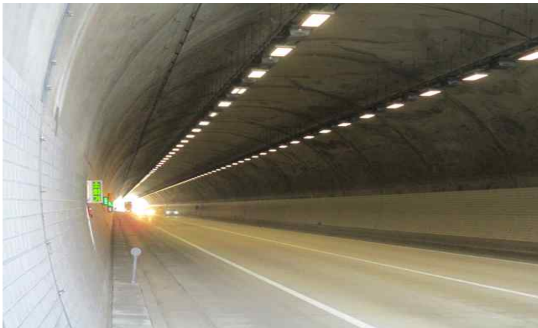
군자1터널(양양) 내부 전경
